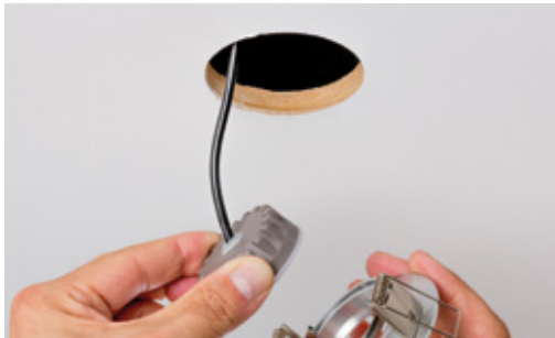
Coin einfach von hinten einsetzen – keine Sprengringe nötig
